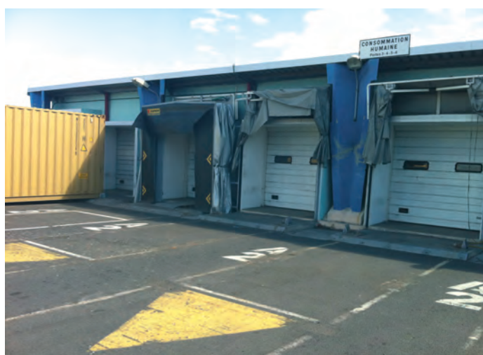
Poste Inspection de la DAAF
