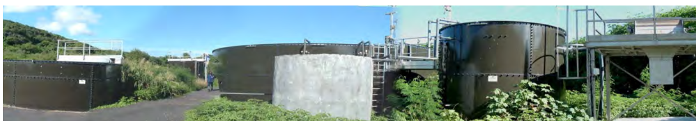
Station d'épuration d'eaux usées
