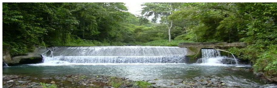
Prise d'eau en rivière
