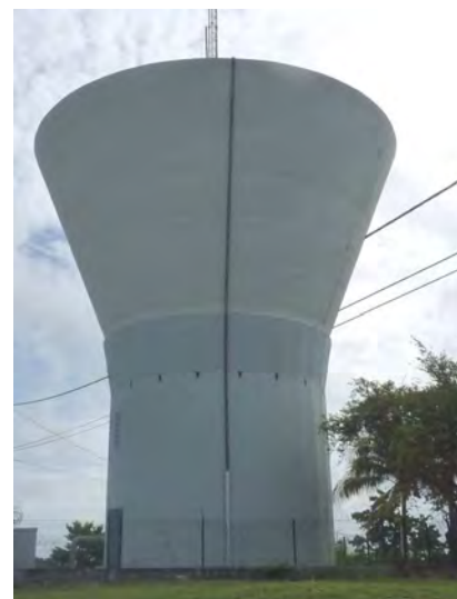
Réservoir d'eau potable sur tour
