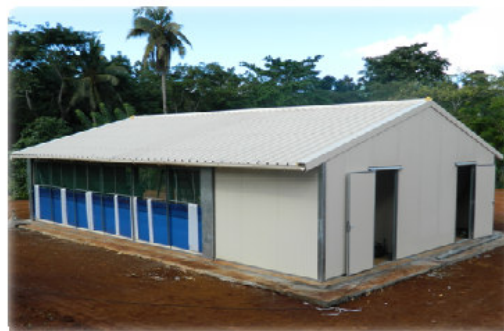
Bâtiment en cours de montage sur l'exploitation du lycée agricole de Coconi
